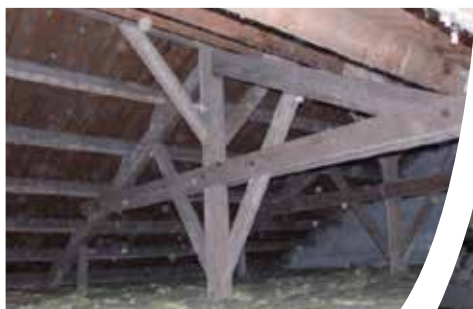
Charpente en combles perdus
