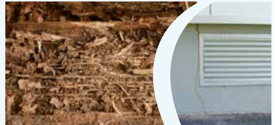
Dégâts de termites sur du bois de chauffage stocké au sol
