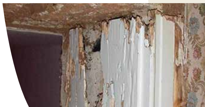
Attaques sur un montant de porte
