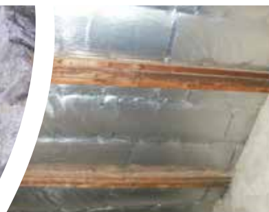
Chevrans masqués par un isolant
