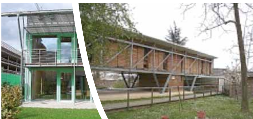
Construction sur poteaux béton
